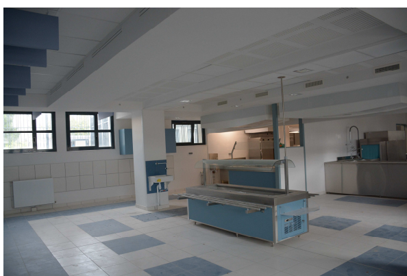
Restaurant scolaire en travaux
