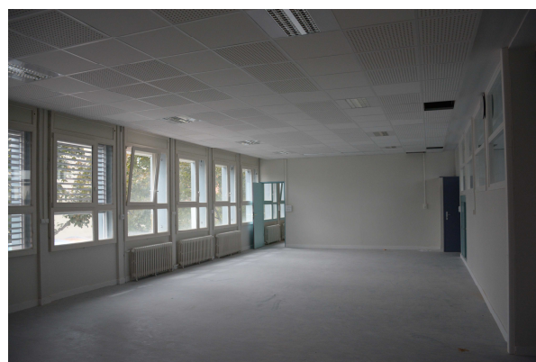
Salle de classe en cours de travaux
